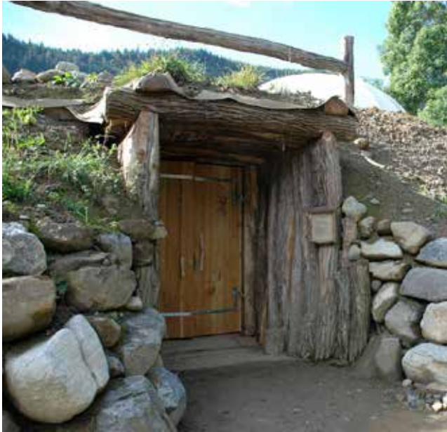
Erdkeller aus Holz. Er bietet eine kühle und feuchte Lagermöglichkeit für Gemüse und Obst.
