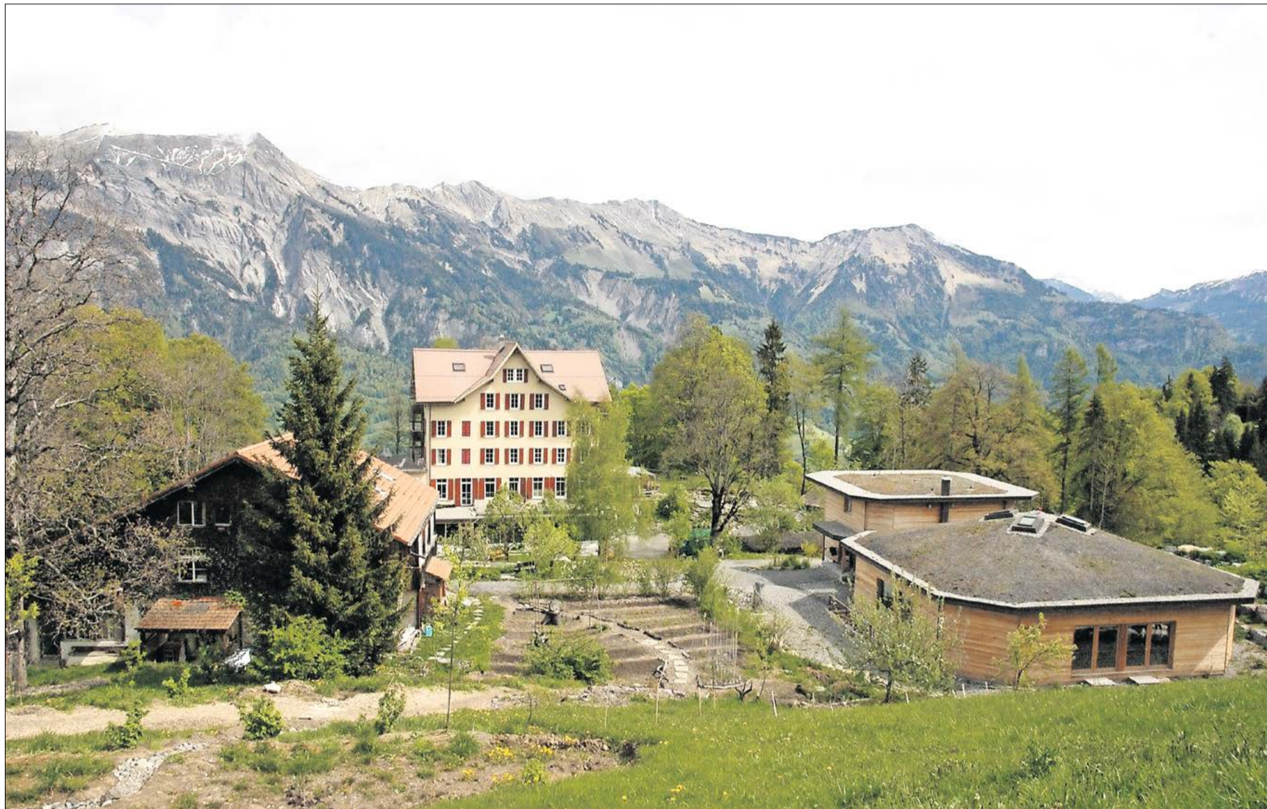
Das alte Gebäude (Bildmitte) war schon einiges: Ein Lungenkurort, ein Kinderspital und ein spirituelles Zentrum. Rechts sind die neuen Seminargebäude.
