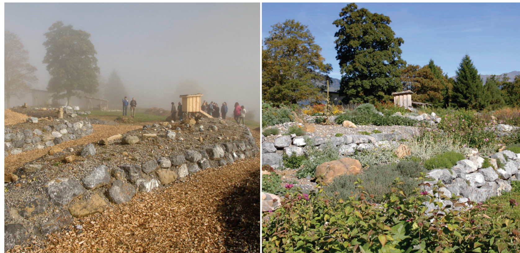
Die Kräuterterrassen sahen nach dem Bau wie eine Steinwüste aus (links). Schon nach einer Vegetationsperiode wuchsen die Pflanzen darin sehr gut und fühlten sich wohl (rechts).
